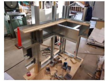
写真11 根太と二階柱
